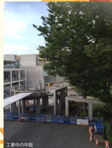
工事中の中庭
